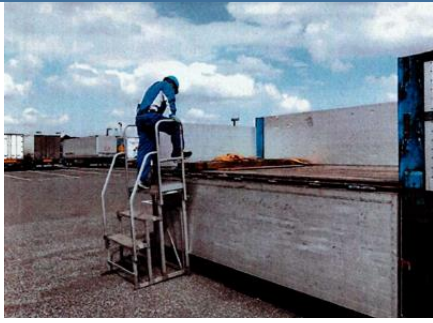
墜落・転落防止：昇降台の導入
